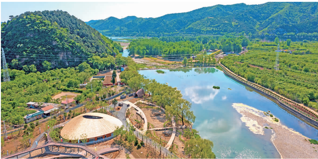
近日,华东公司承建的天津市蓟州州河国家湿地公园工程13个分部工程顺利通过验收,湿地公园基本具备开园条件。蓟州州河国家湿地公园是天津市4个国家湿地公园试点之一,项目建设规模508.2公顷,为京津冀地区稀有动植物资源保护与人居环境生态建设提供了典范,为“绿色蓟州”发展贡献天航力量。图/文 杜弘扬
