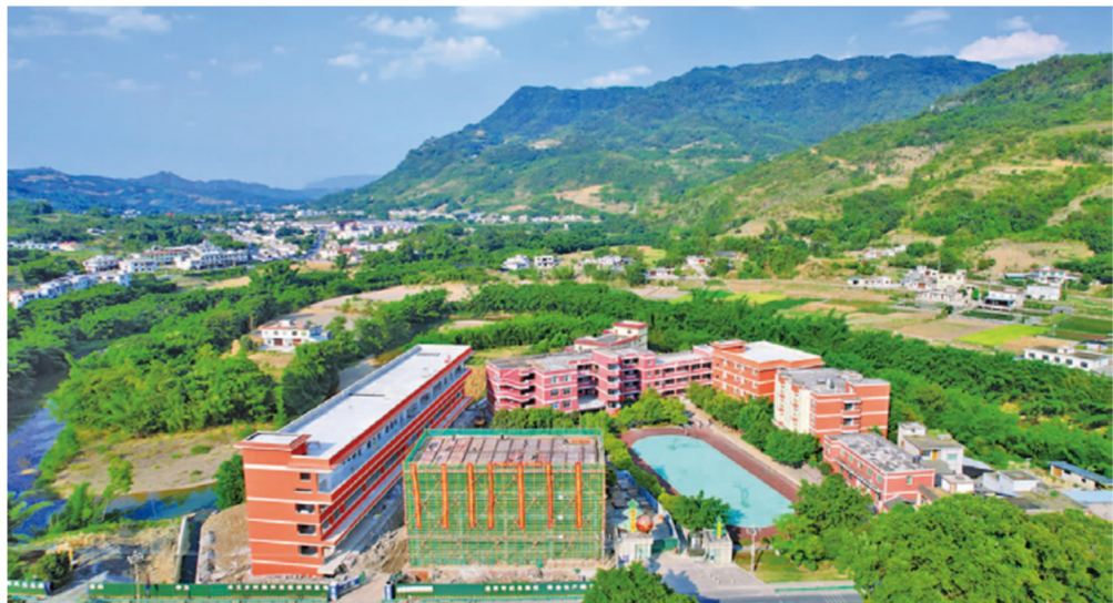
9月1日，南方公司宜宾兴文乡村振兴寄宿制学校项目首批新建教辅楼、教学楼等教学设施投入使用。本次投入使用的包括侨心小学、五星中学等8所学校的1栋教学楼、11栋宿舍楼等，新增学位近3000位、床位近4500位，为留守儿童提供了更加舒适的学习和生活环境。图/文 熊浩
