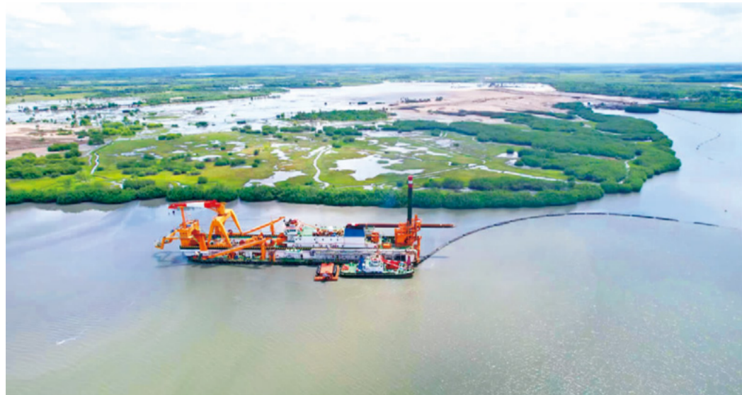
9月2日，疏浚公司贝宁阿海梅湖疏浚工程一区顺利完工，该工程一区设计工程量532.54万方，完工后可畅通阿海梅湖内鱼类回游通道，恢复水生生物种类，改善水体质量，促进生态修复，为后续阿海梅湖及其河道经济区的综合开发奠定基础。图/文 马骁 祝世路
