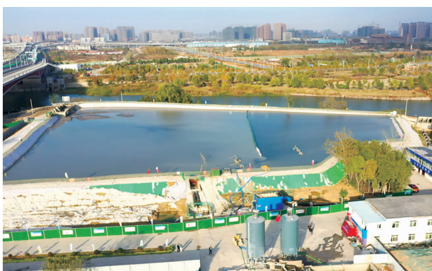
日前,由上海公司承建的南淝河下游环境综合整治工程底泥清淤EPC总承包项目获得业主单位(合肥市包河建设发展投资有限公司)表彰,上海公司获评年度“优秀施工企业”,项目经理仰建国获评年度“优秀项目经理”。(李圣斌摄影报道)
