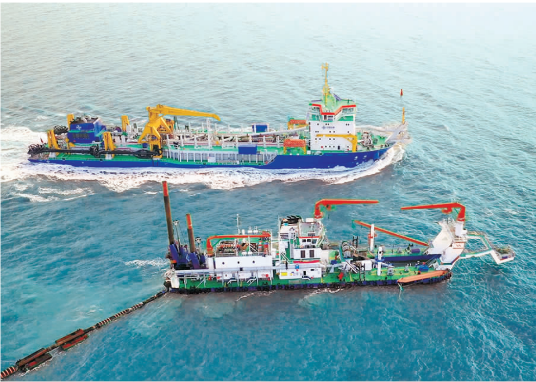
1月2日,天津临港产业投资控股有限公司发来感谢信,并在高沙岭项目部举办赠送锦旗仪式,感谢滨海公司圆满完成2019年度高沙岭项目施工任务。天津港高沙岭港区10万吨级航道一期工程航道设计长度22千米,疏浚工程量1882万方,2019年计划完成产值的30%。(王海鹰 魏新亚摄影报道)
