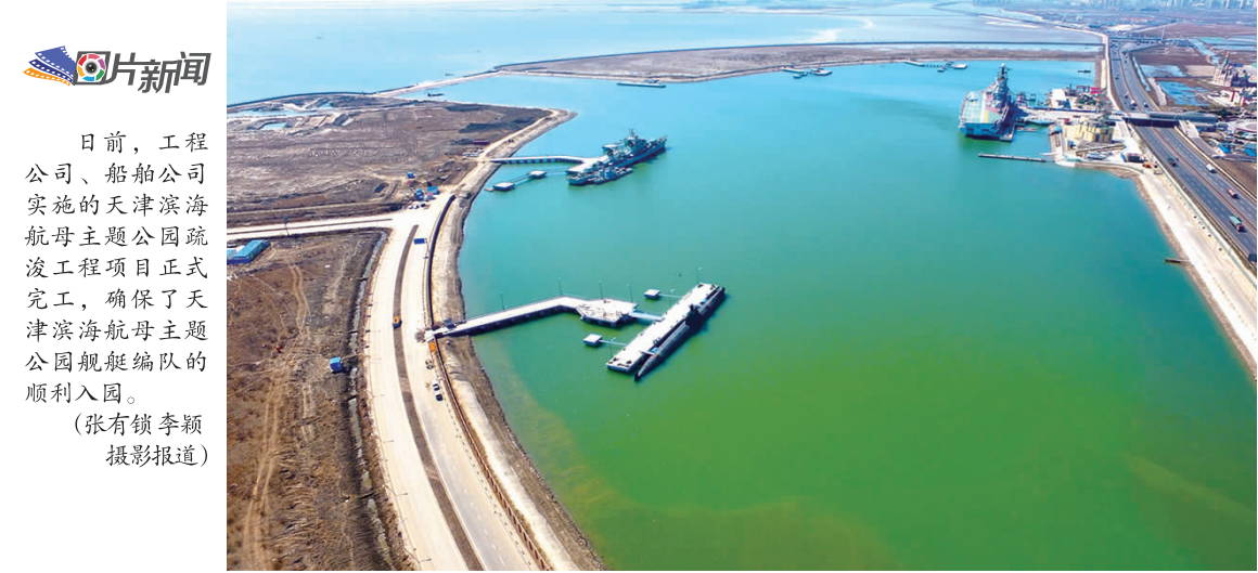
日前,工程公司、船舶公司实施的天津滨海航母主题公园疏浚工程项目正式完工,确保了天津滨海航母主题公园舰艇编队的顺利入航。(张有锁李颖摄影报道)
