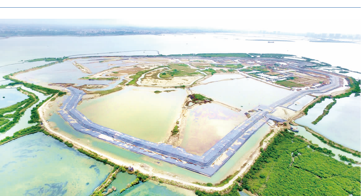
4月5日,工程公司、船舶公司承建的茂名市水东湾水域清淤整治项目二期工程顺利完成2.7Km围堰充填袋施工,提前完成业主要求的2.5Km节点工期目标。(魏永旭摄影报道)
