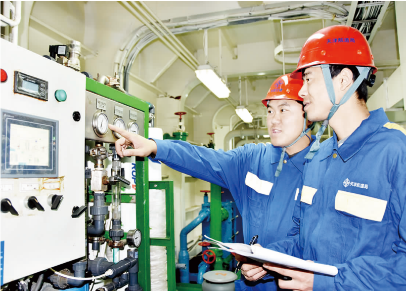
图为“天骅”船船员正在记录海水淡化设备运转数据
