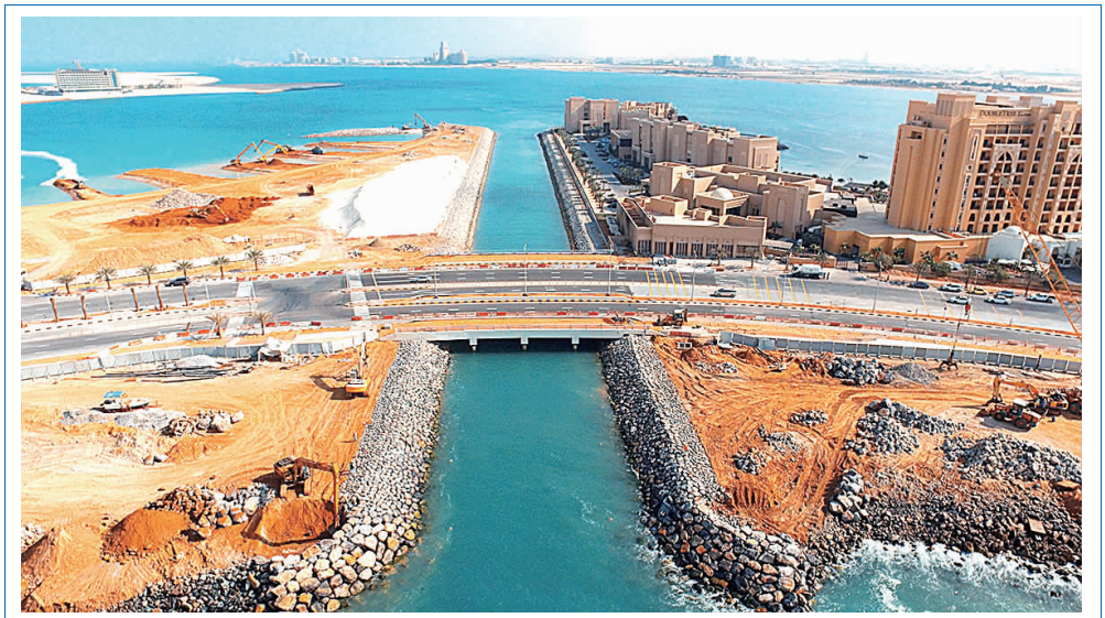
1月9日,天航局施工的阿联酋珊瑚岛桥梁工程及过水通道工程完成全部施工,进入交工验收阶段。施工过程中,项目部严格按照工期和质量要求,克服了气候恶劣、工况复杂及施工交叉干扰等不利因素,如期完工,受到了业主的高度赞扬,被业主称为“Chinese Style”(中国风)。(任浩琳摄影报道)
