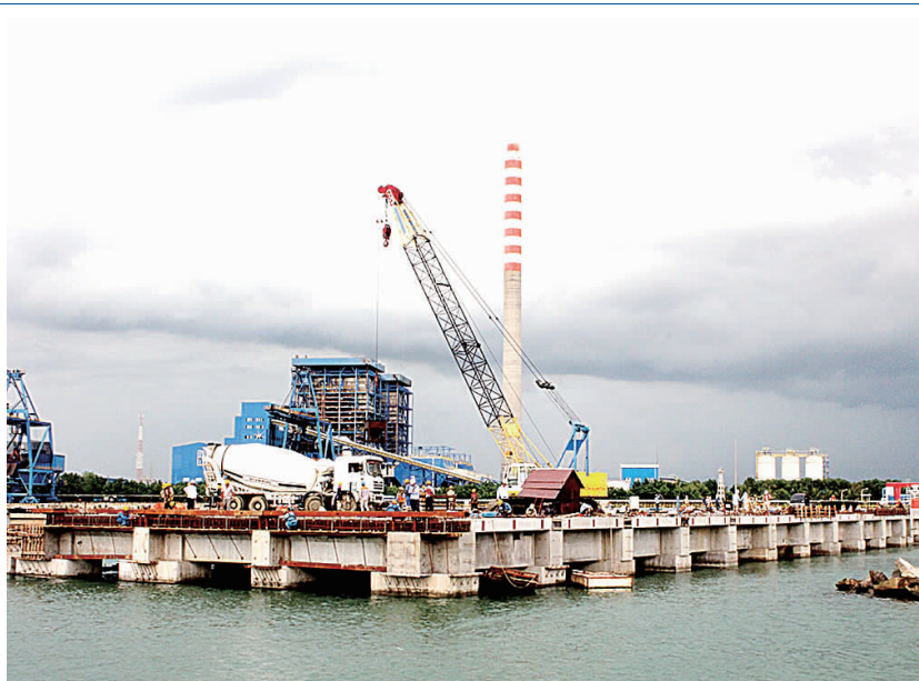
日前,由工程公司印尼芝拉扎项目部承建的印尼芝拉扎电厂水工工程建设项目 1.4 万吨驳船码头预制构件安装已全部完工,共安装各类构件 267 件。图为施工现场。(李秋健 摄影报道)
