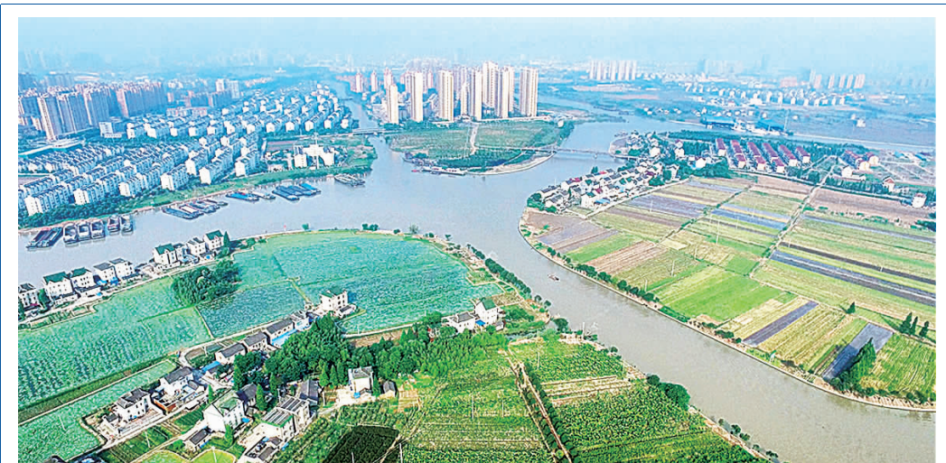
日前，环保公司承建的杭平申线（浙江段）航道改造工程平湖段工程历时2年顺利完工。施工内容包括航道护岸砌驳、开挖航道土、修筑防撞墩、老构筑物拆除以及护岸踏步修复等。工程建设对浙北地区实现海河联运、提升航道等级和防洪能力、造福地方百姓具有重要意义。（李颖 邵炎频 摄影报道）
